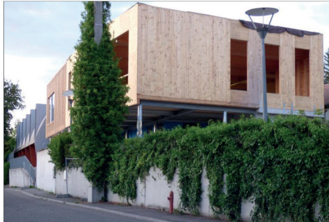
Le chantier de l'extension de l'Espace Terminus se poursuit. Photo DNA
